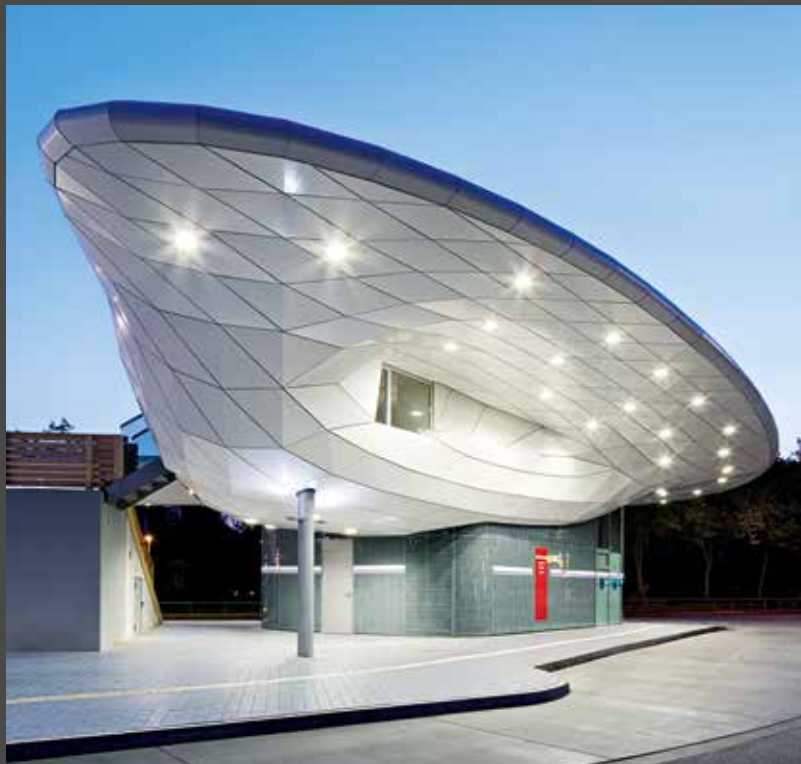
O teto em forma de asa flutuante da Estação Rodoviária Poppenbüttel, executada em ALUCOBOND® pure white. | Imagem: archimages
