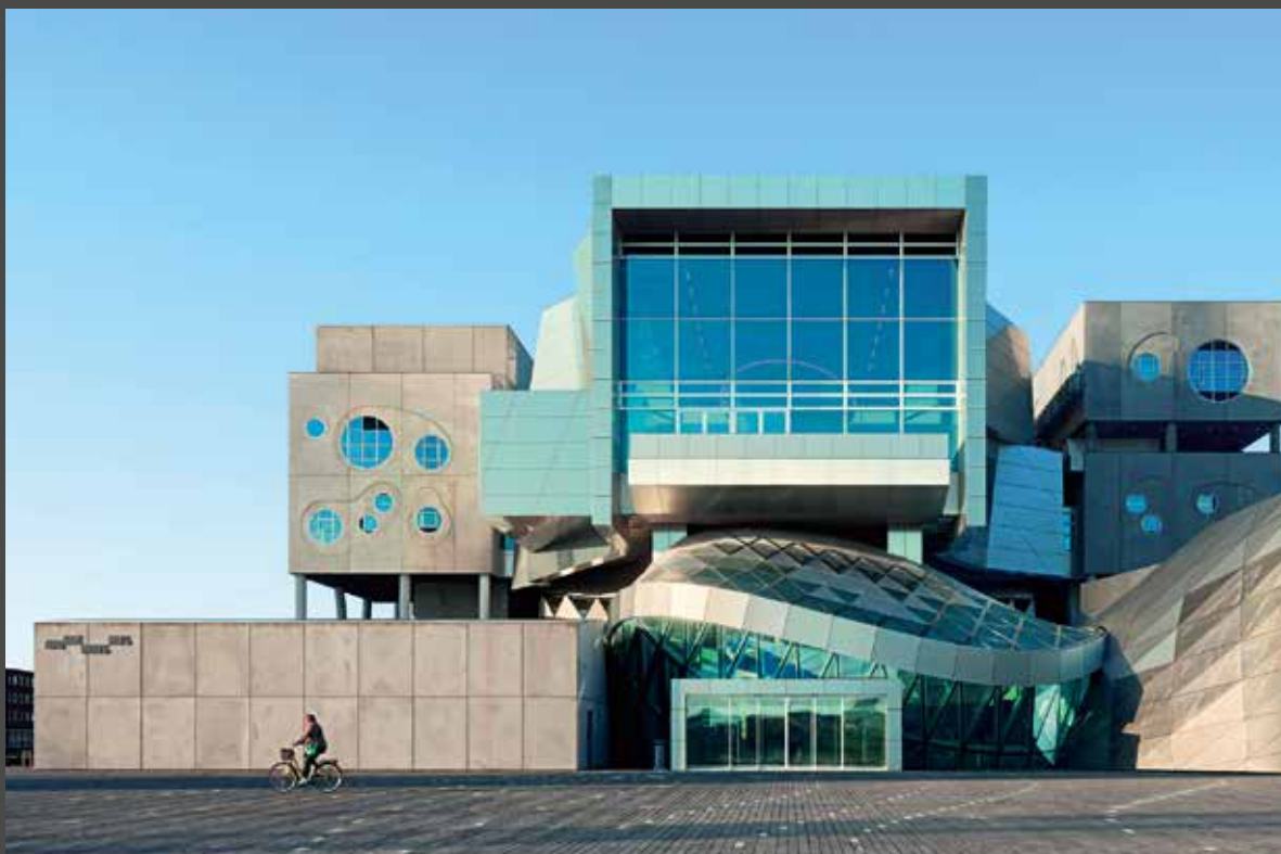
O ALUCOBOND® painel compósito em natural Brushed dá ao edifício o seu carácter distintivo. | Imagens: Duccio Malagamba
