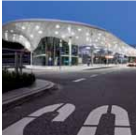
Blunck + Morgen Architekten, WTM Engineers, Hamburg, (DE) Busbahnhof Hamburg-Poppenbüttel, (DE)
