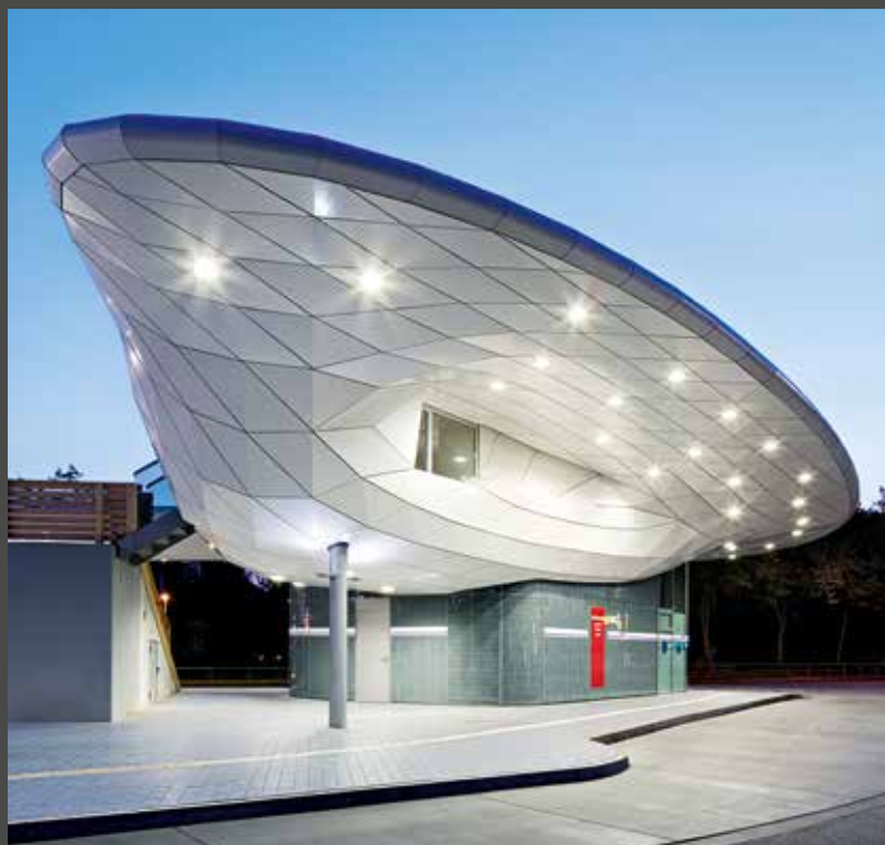
O teto em forma de asa flutuante da Estação Rodoviária Poppenbüttel, executada em ALUCOBOND® pure white. | Foto: archimages
